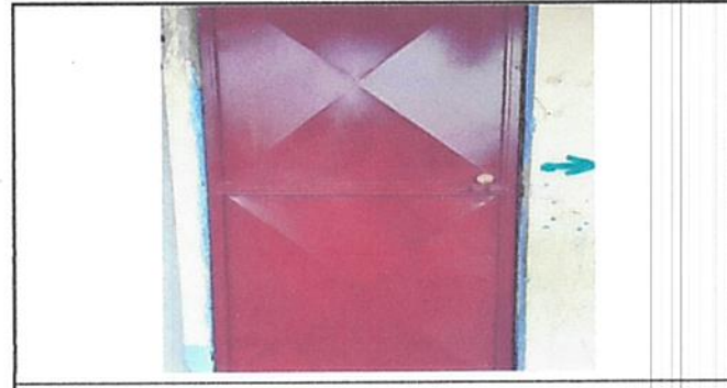
Foto 6: Mantenimiento puertas aulas
