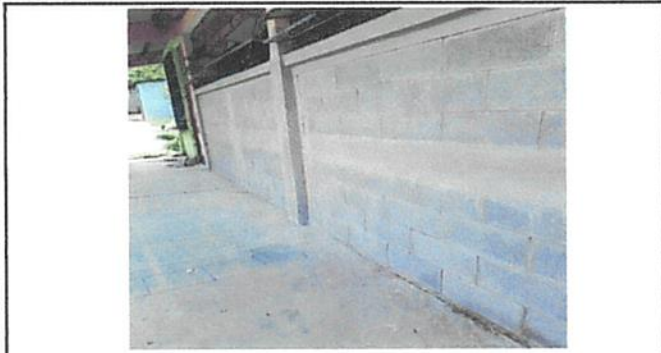
Foto 1: Reparación de pared
