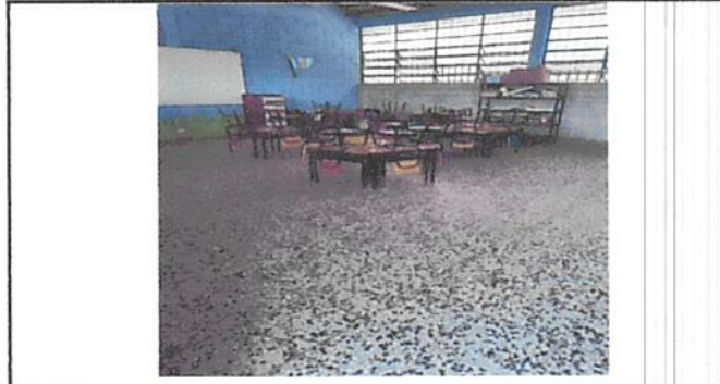
Foto 2: Instalación piso granito
